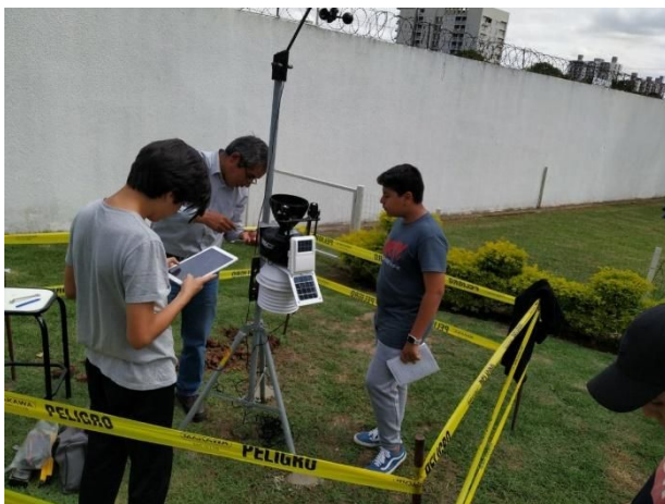
Installation de la station avec un technicien venu de La Paz, Mr Carlos Chambi.
